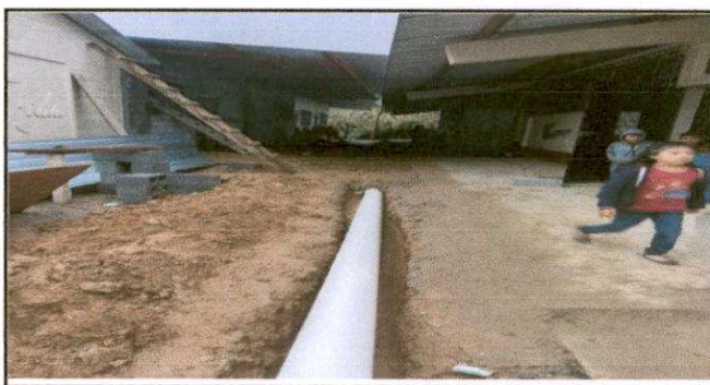
Foto 6: Sustitución de tubería PVC línea principal de aguas negras
