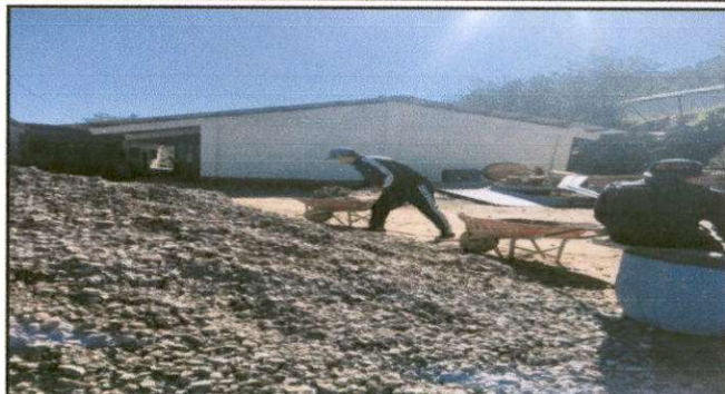
Foto 2: Instalación de 130 M2 de piso de torta de concreto de 6cm.
