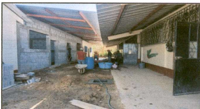
Foto 4: Instalación de 120 M2 de piso de torta de concreto de 6 cm.
