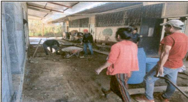
Foto1: Sustitución de tubería línea principal agua potable 20 ML.
