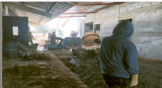
Foto 3: Instalación de 120 M2 de piso de torta de concreto de 6 cm.
